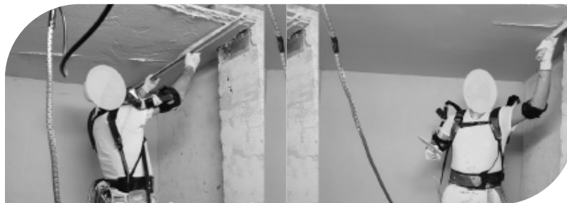
Figuur 5a. Overzicht van de opstelling en de werkzaamheden aan het plafond. Afreien (links) en afwerken met een pleisterspaan (rechts).
