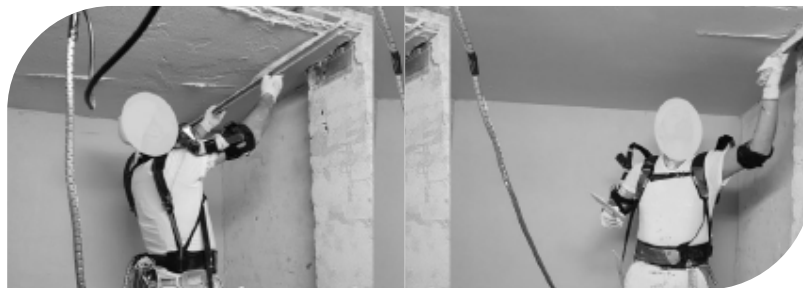
Fig. 5a. Vue d'ensemble de la configuration et des activités au plafond. Lissage (à gauche) et finition avec une spatule à plâtre (à droite).
