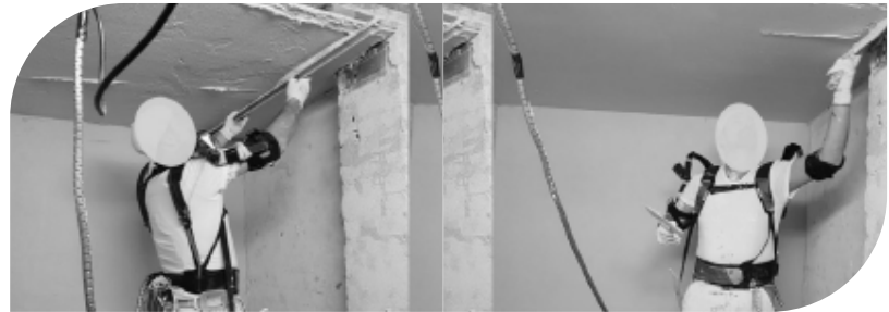
Abb. 5a. Überblick über den Versuchsaufbau und die Arbeiten an der Decke. Abziehen (links) und Glätten mit einer Spachtel (rechts).
